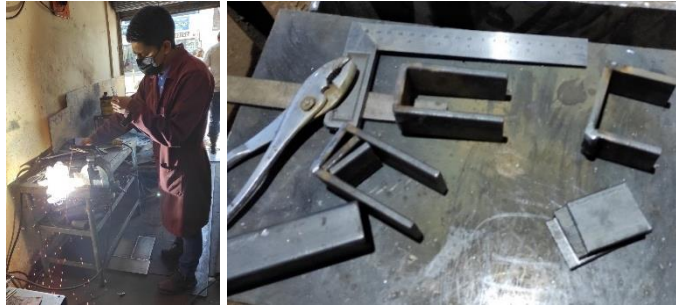
Figura 43-3: Soldadura de los soportes y bases de las manguetas
