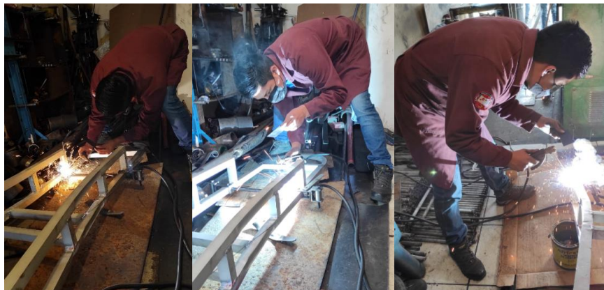
Figura 53-3: Soldadura del travesaño y puente inferior
