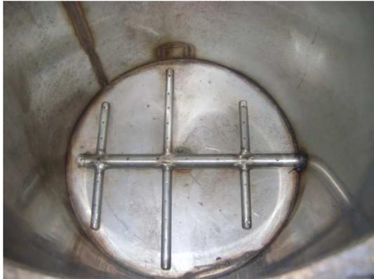
**Figura 5.9. Distribuidor de salida del vapor**
