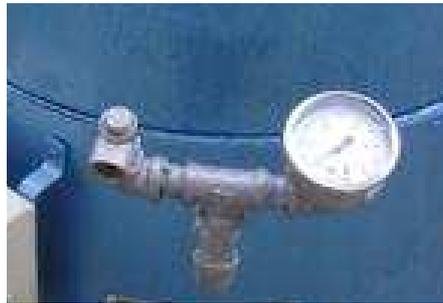
**Figura 5.20. Válvula de seguridad y manómetro**
