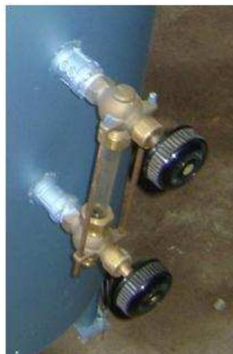
**Figura 5.19. Medidor de nivel**
