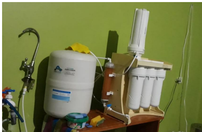
Figura 10-3: Equipo de ósmosis inversa
