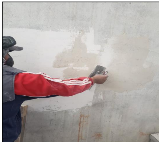
Fotografía 11-3: Aplicación de la segunda capa de empaste formulado.
