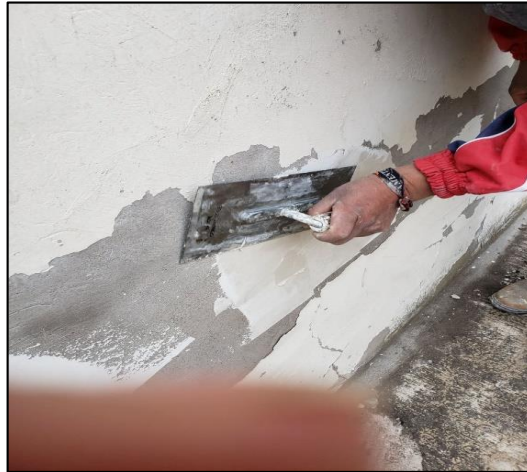
Fotografía 10-3: Aplicación de la primera capa de empaste formulado.
