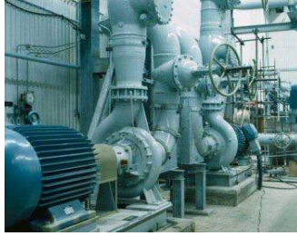
Figura 2.6: Bomba centrífuga
