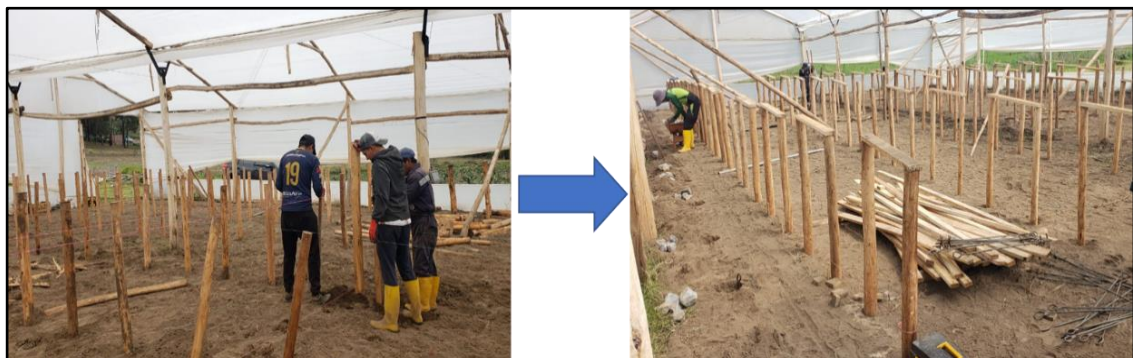
Figura 1-2. Establecimiento de la estructura interna para un cultivo de fresa semi-hidropónico.
