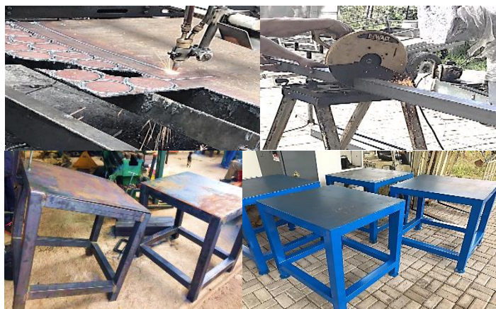
Figura 20-3: Construcción de la mesa de trabajo.
