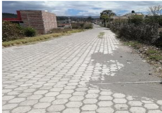
Figura 10-3: Zona urbana sin señalética
