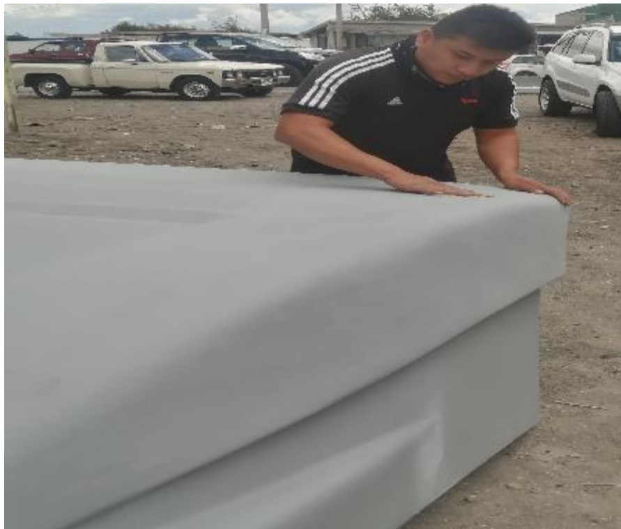
Figura 7-3: Lijado de imperfecciones superficiales del deflector.
