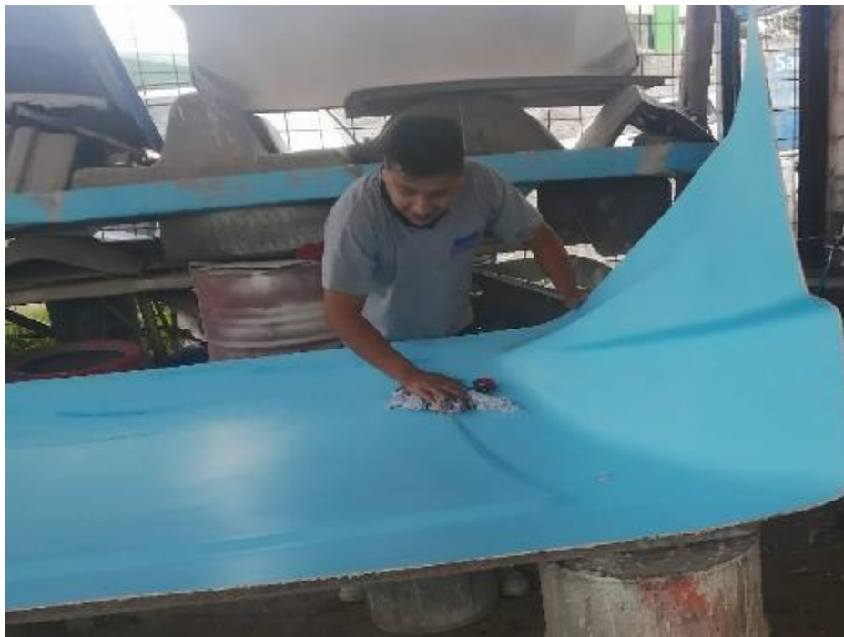
Figura 3-3: Limpieza de la matriz para iniciar la construcción del deflector
