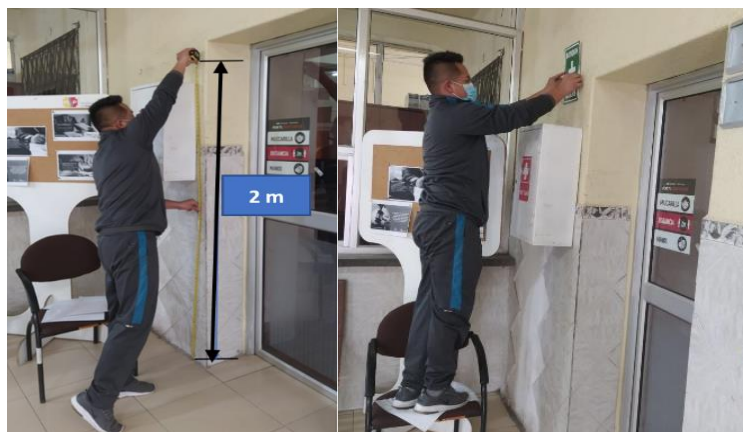
Figura 1-4. Implementación de señalética a 2 m de altura - NTE INEN 2239
