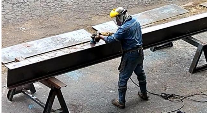
Figura 7-3: Subproceso de pintura - preparación superficial
