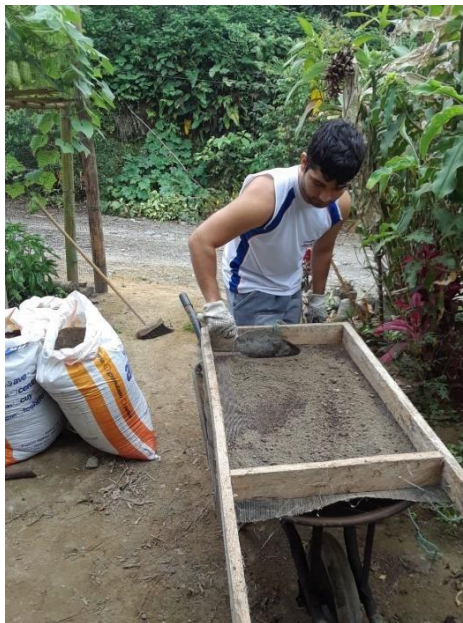
Figura 7-2. Proceso de tamizado de la arena
