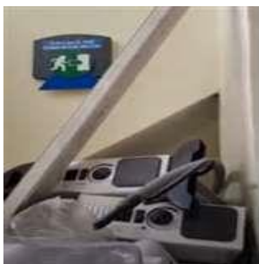
Figura 5-3. Salida de emergencia con posible caída de objetos
