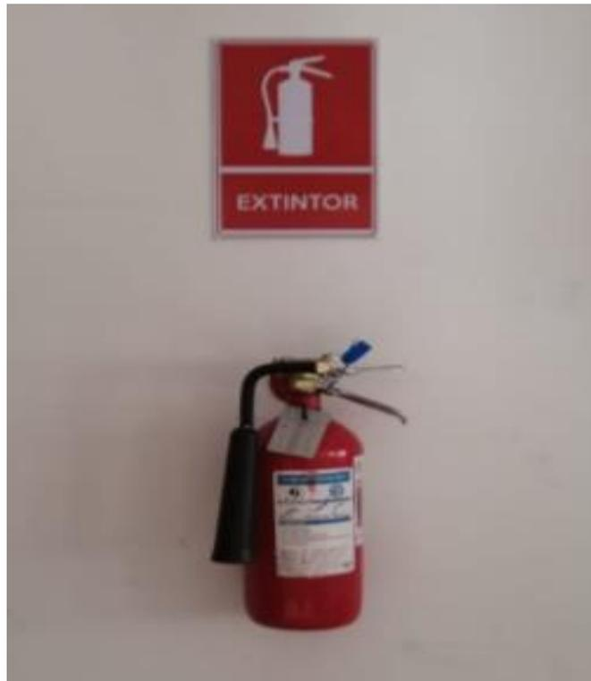
**Ilustración 5:** Ubicación de los extintores bajo la norma NFPA 10
