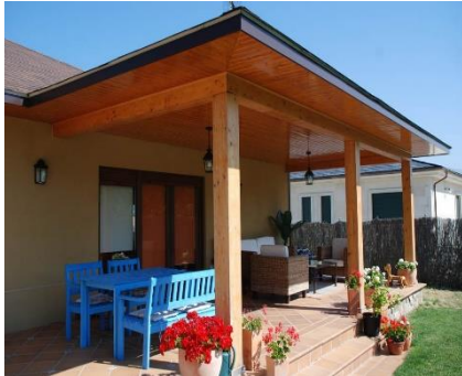
Figura 3-2: Pilares de madera
