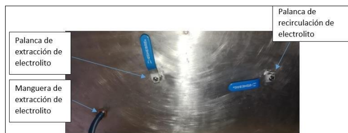
Figura 16-3. Panel de control (recirculación de electrolito)
