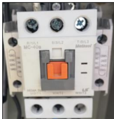
Figura 2-2. Contactor
