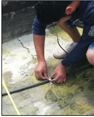
Figura 13-3. Instalación del sistema por recirculación
