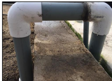
Figura 8-3. Tubería de succión del sistema por recirculación
