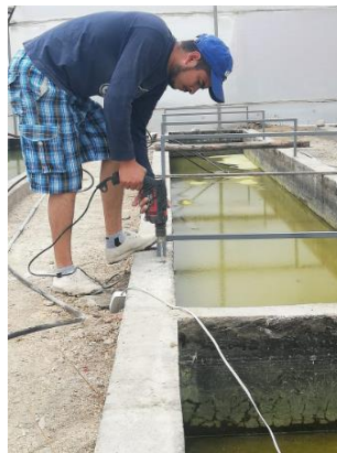
Figura 22-3. Instalación del sistema por gravedad
