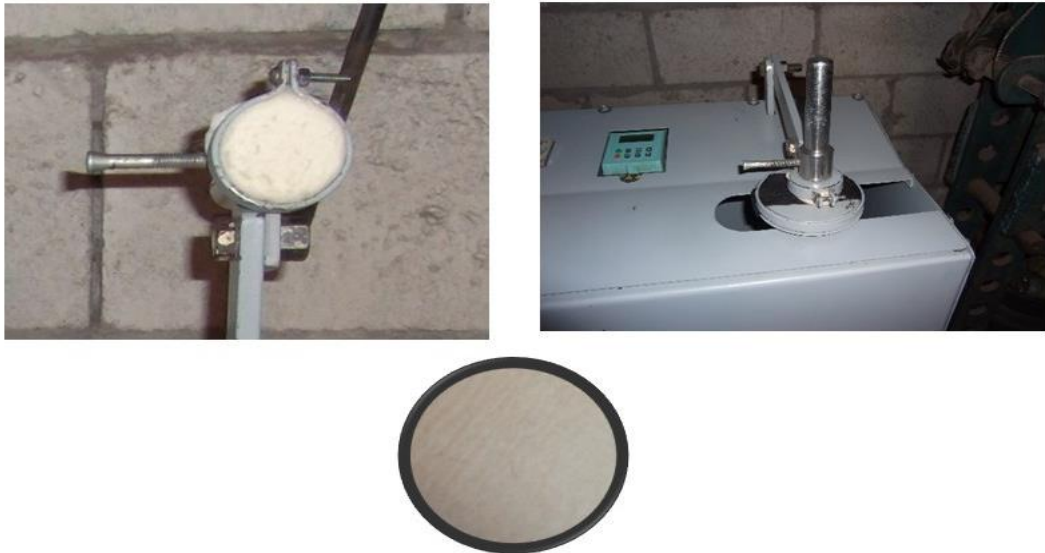
Figura 12-2. Filtro manchado después de la medición de la resistencia al frote en seco
