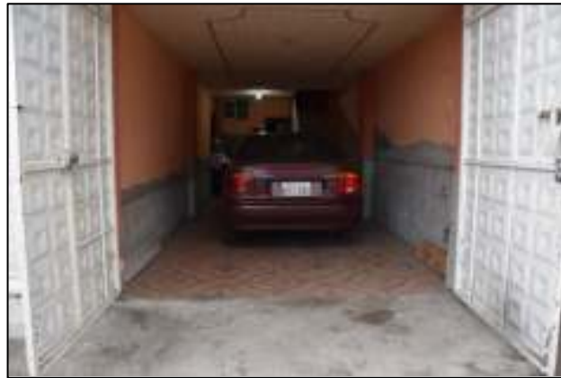
Figura 10-2: Vehículo al interior de un garaje sin incidencia solar
