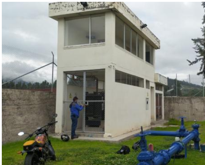
Foto 33 y 34: Pozo el Estadio, para el abastecimiento de la Parroquia Yaruquies.
