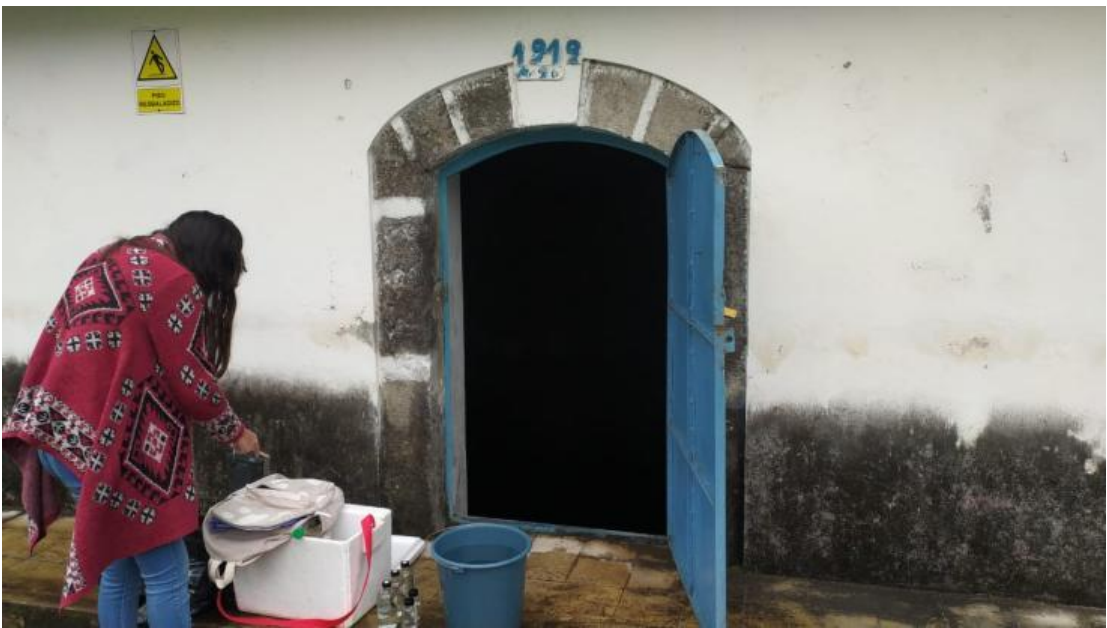
Foto 25: Infraestructura del pozo San Pablo.
