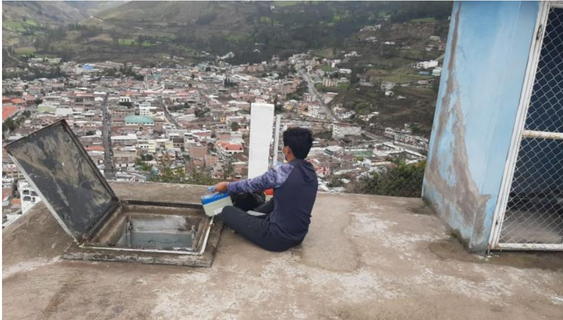
Foto 12 Tanque reservorio de Chitaquies, conectado a la red principal.
