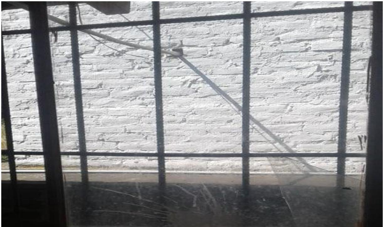
**Imagen 8:** Los vidrios de las ventanas que posee la planta no son de material inastillable.
