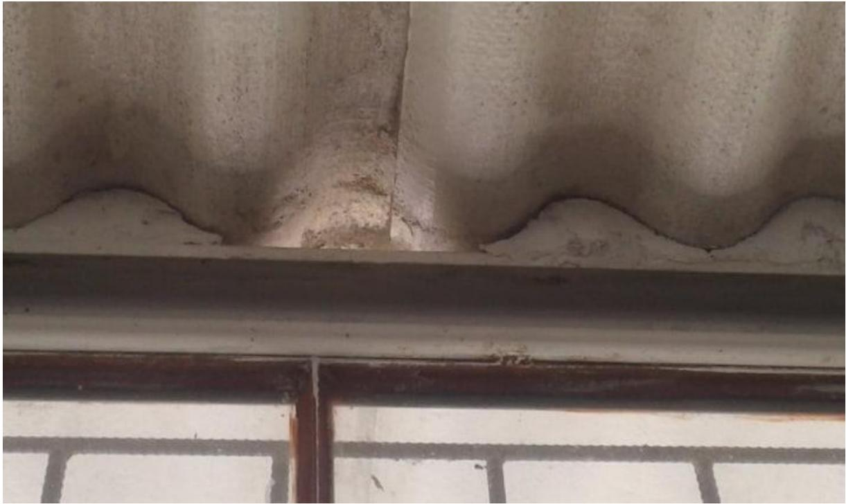
**Imagen 1:** Presencia de orificios en el techo.
