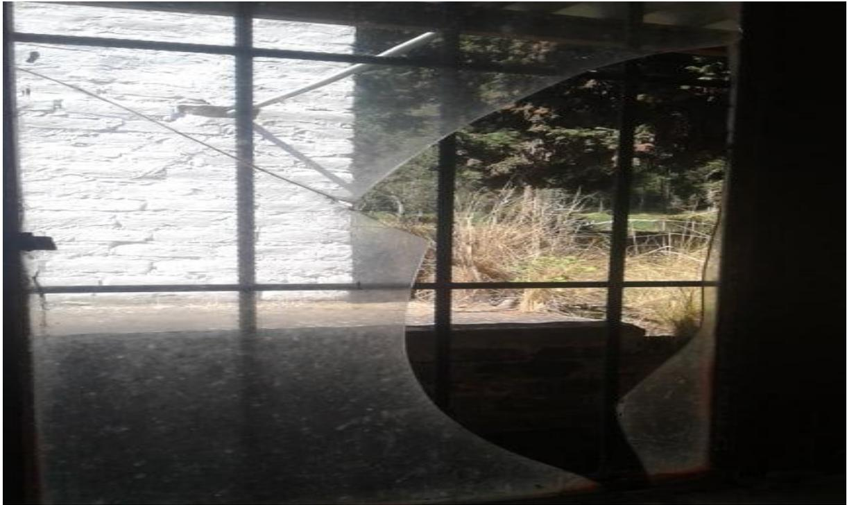
**Imagen 3:** Presencia de vidrios rotos en las ventanas de las áreas de proceso.
