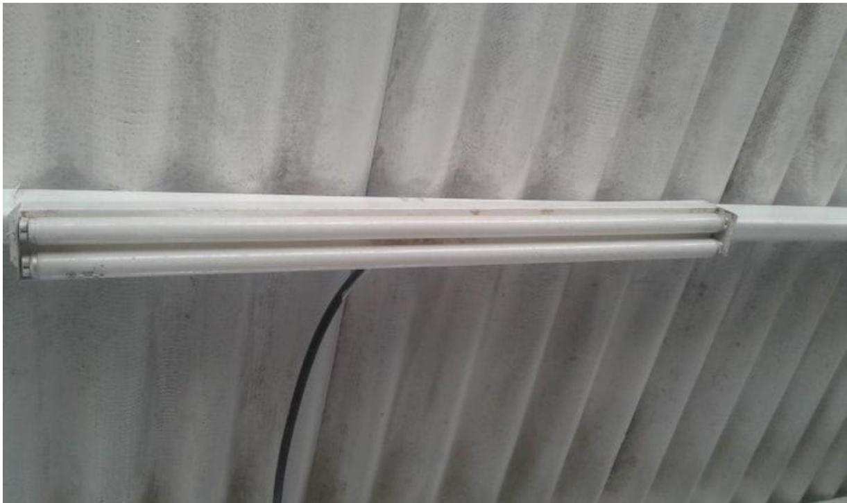
**Imagen 10:** Los focos fluorescentes de la planta no cuentan con protección de seguridad.
