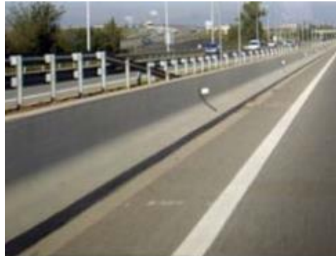
Figura 2.2 Barrera de hormigón Realizado por: Eupave, 2012
