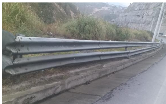
Figura 1.2 Barrera metálica Realizado por: Autor
