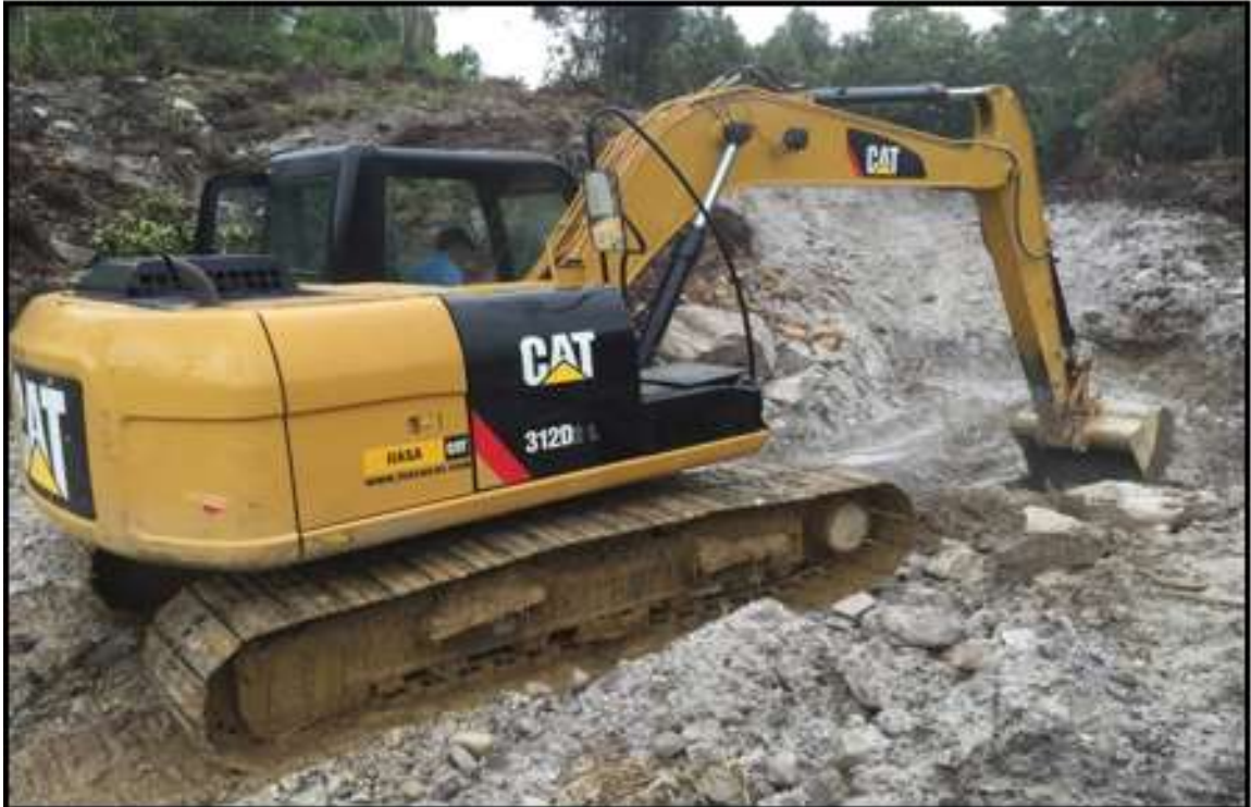
Figura 2-3: Excavadora 312D Utilizada en las Labores de Exploración.
