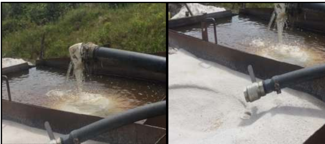
Figura 1-8: Tanques de Lavado
