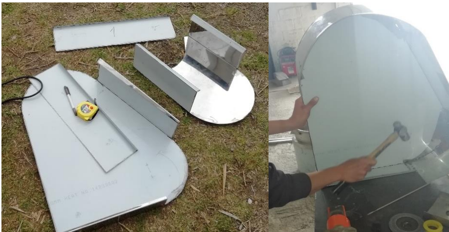
Figura 37-3. Corte, construcción y soldadura de los protectores.
