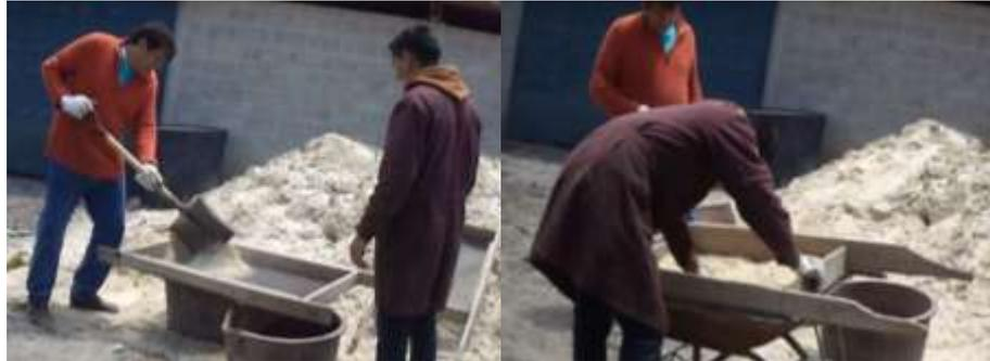
**Figura 67-3.** Obtención de arena fina de sílice mediante zarandeo
