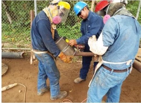
Figura 15-2: Armado de la junta.
