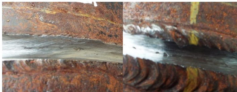
Figura 34-2: Inspección visual del área de corte.
