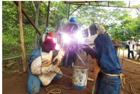
Figura 16-2: Ejecución del proceso de soldadura.
