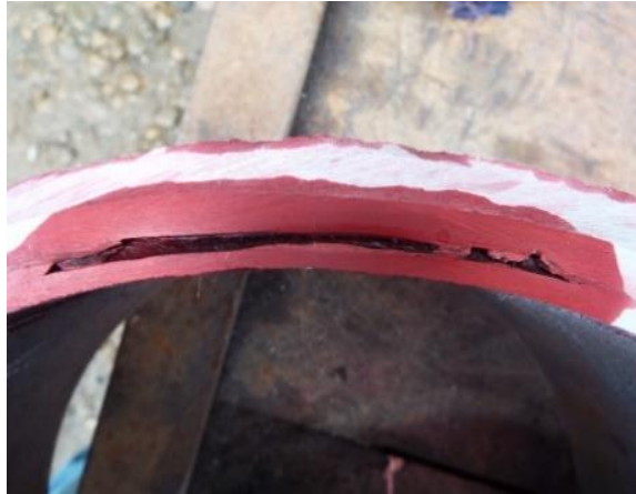
Figura 19-2: Falta de fusión.
