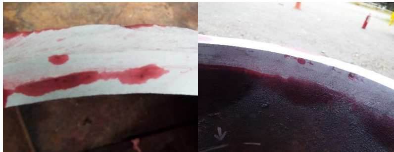
Figura 35-2: Inspección mediante líquidos penetrantes.
