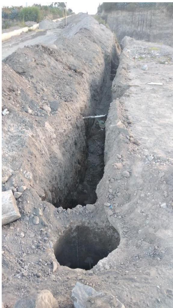
**Figura 2- 3:** Excavación para el ruteo de tubería
