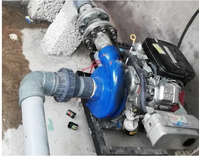
**Figura 5- 3:** Motobomba instalada en el sistema
