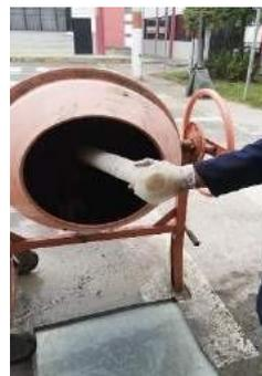
**Imagen 2.-** Añadir los materiales en la concretera y mezclar
