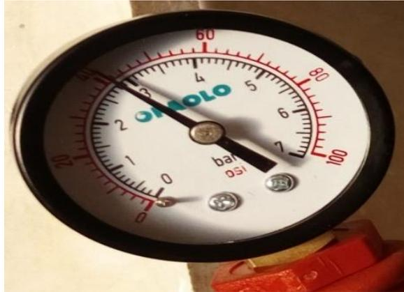
**Figura 2-3.** Toma de presión de la red de alimentación de agua potable.
