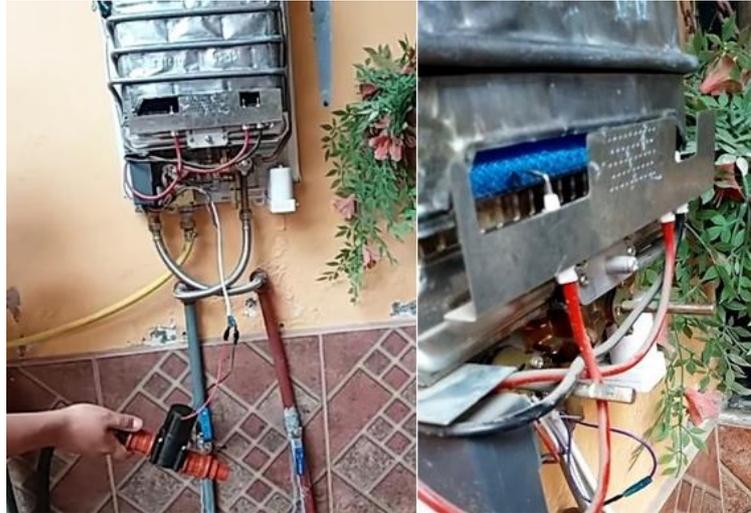
**Figura 28-4.** Encendido calefón GWH6 B31 por micro generación.
