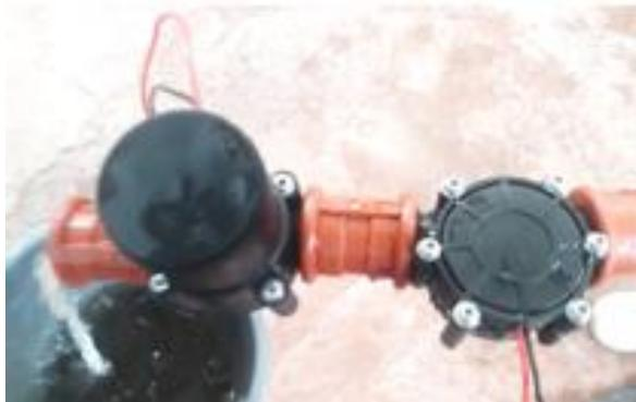
**Figura 3-3.** Medición sensor de flujo YF-S201.
