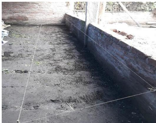
**Figura 5-2:** Señalización del área a construir.
