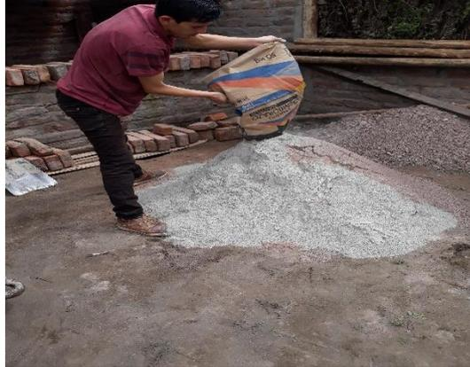
**Figura 6-2:** Cemento y agregado fino.
