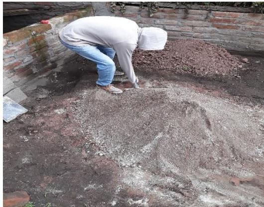
**Figura 7-2:** Mezcla del agregado fino con el cemento.
