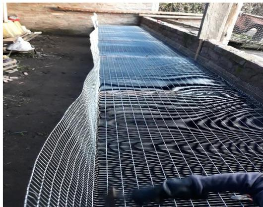
**Figura 10-2:** Colocación de malla metálica.
