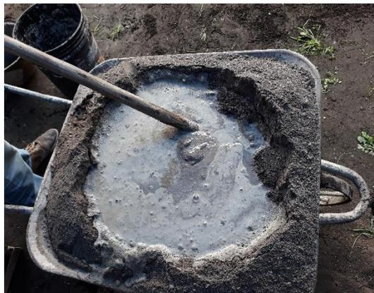
**Figura 8-2:** Mezcla del agregado fino, cemento y agua.
