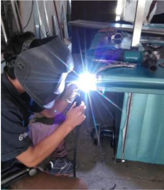
Armado de colector
