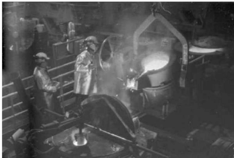
Figura 3-2. Colada de hierro fundido en moldes.
