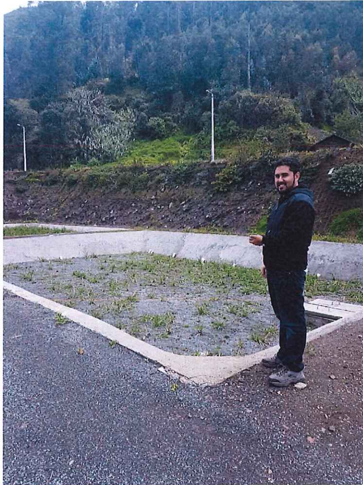
Fotografía 1. Planta de tratamiento de aguas residuales Pachanillay - Parroquia El Altar
