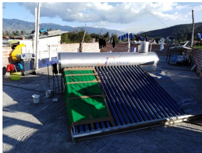
Figura 5-B: Para evitar el exceso de temperatura se procede a tapar los tubos.
