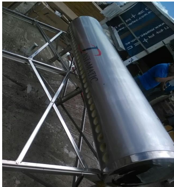
Figura 2-B: Armado del tanque de 300 litros sobre el soporte metálico.
