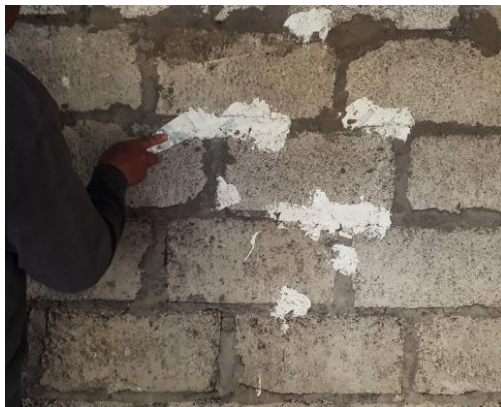
C.1 Colocación de masilla en habitación de construcción antigua.
