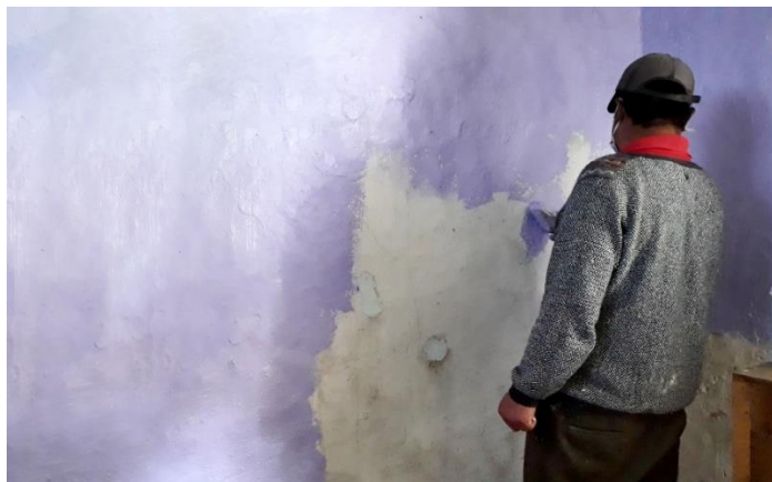
F.1 Aplicación del esmalte en habitación de construcción antigua.
