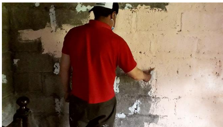
F.2 Aplicación del esmalte en habitación de bloque.
