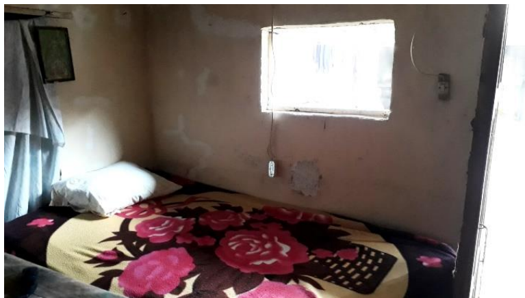
D.1 Apertura de ventanas y puertas en habitación de construcción antigua.
