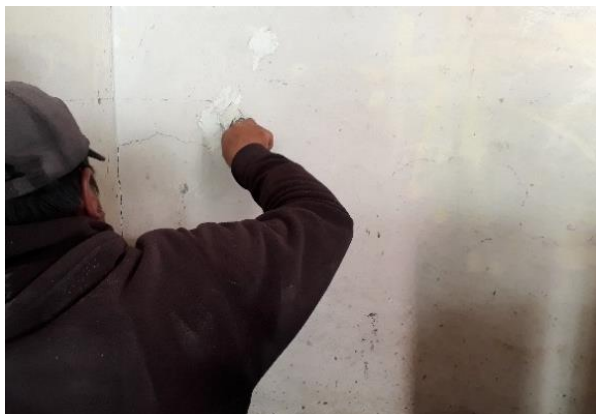
C.1 Colocación de masilla en habitación de construcción antigua.
