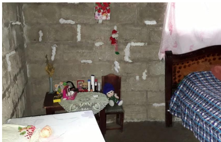
G.2 Toma de concentración en vivienda de bloque.
