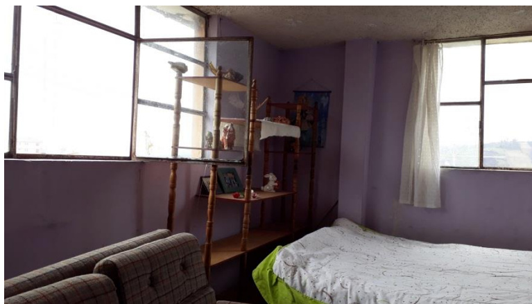
D.3 Apertura de ventanas y puertas en habitación de construcción mixta.
