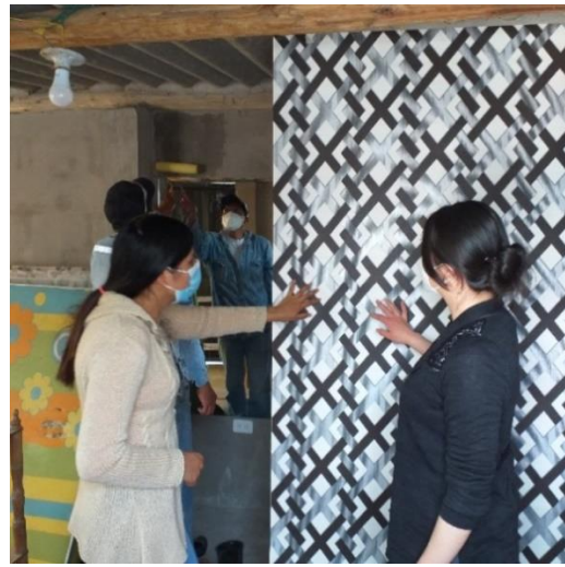
E.4 Instalación del tapiz en vivienda mixta.
