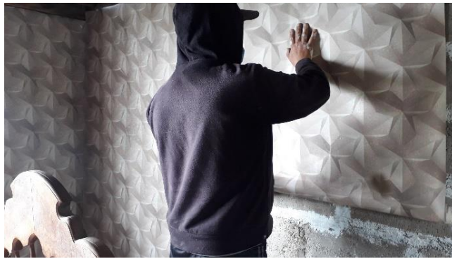
E.5 Instalación del tapiz en vivienda de bloque.
