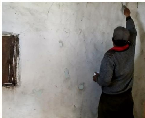
C.1 Colocación de masilla en habitación de construcción antigua.
