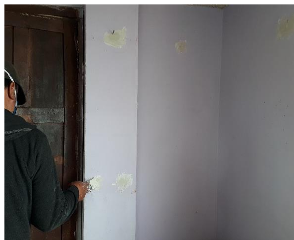
C.3 Colocación de masilla en vivienda mixta.
