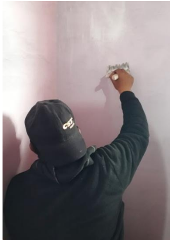
E.1 Aplicación de goma blanca.
