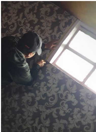
E.3 Instalación del tapiz en vivienda antigua.
