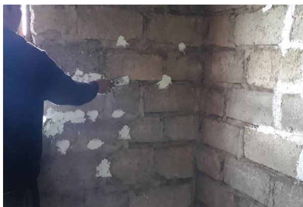
C.2 Colocación de masilla en habitación de bloque.
