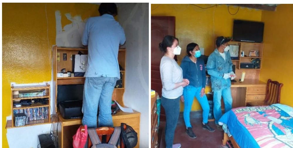
F.3 Aplicación e inspección del esmalte en habitación de construcción mixta.
