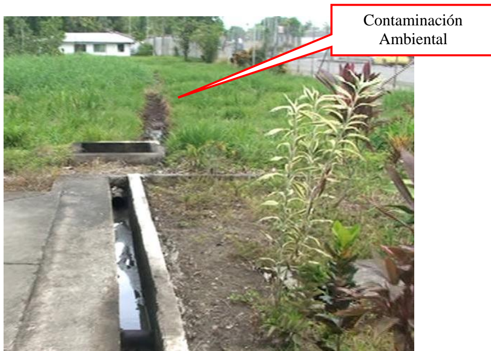
Figura 2.13 Contaminación de las trampas de grasa
