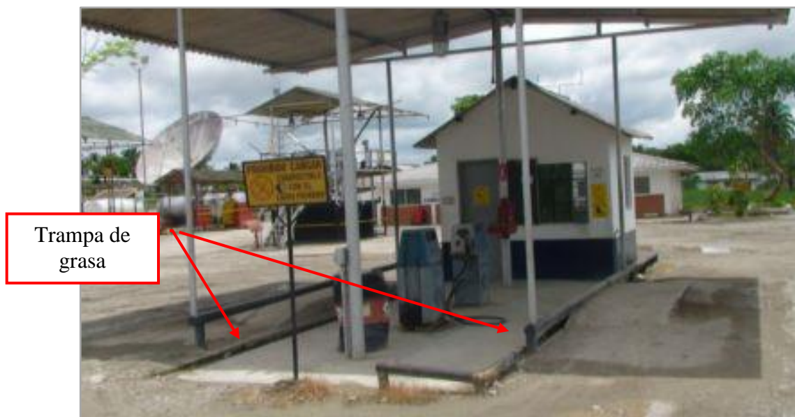
Figura 2.10 Trampa de grasa en las despachadoras en mal estado.
