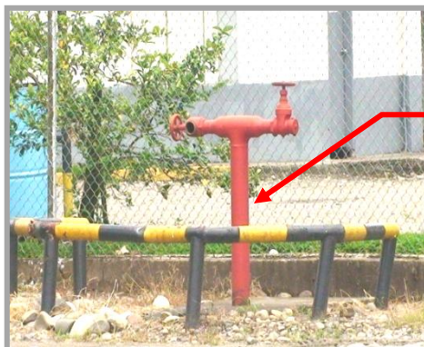
Figura 2.4 Hidratante. Sistema fijo de espuma (XL-3)
