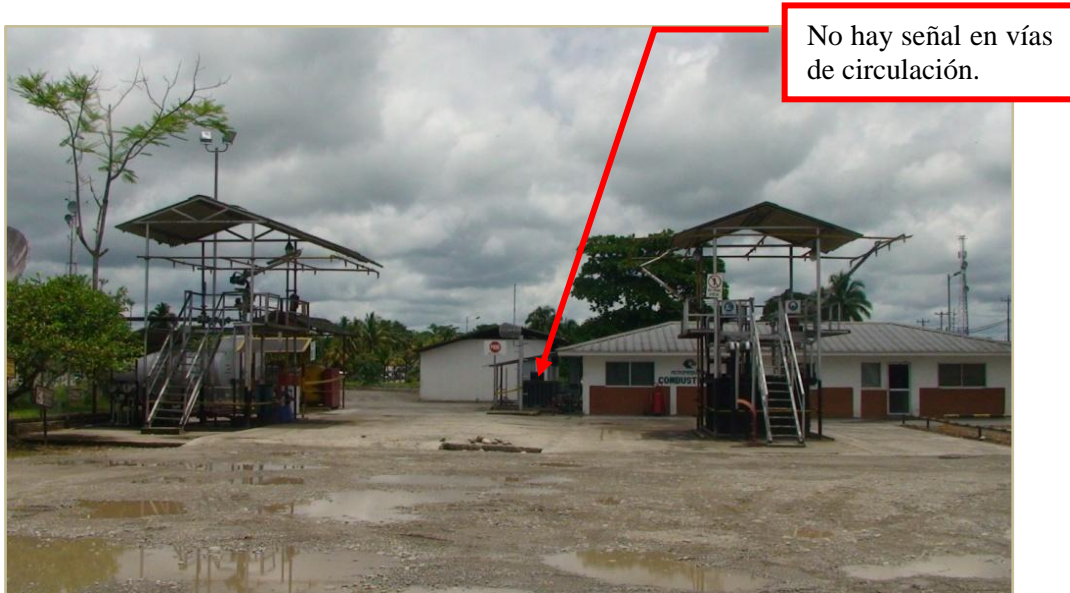
Figura 3.43 Falta de señalización de vías de circulación.
