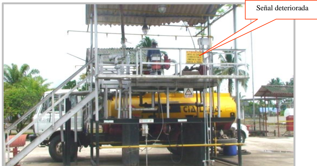
Figura 2.7 Escasa señalización (EPI) y falta de señalización en áreas de trabajo.
