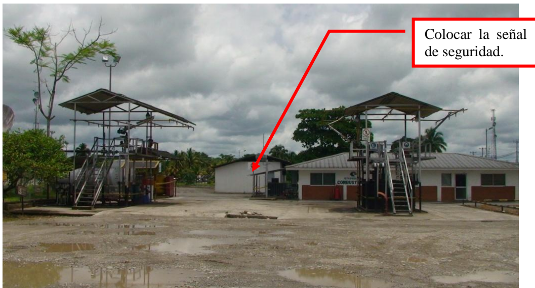
Figura 3.44 Señalización de las vías de circulación de peatones.
