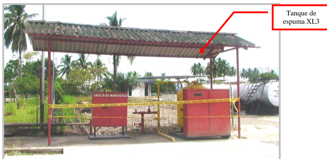
Figura 2.5 Sistema fijo de espuma
