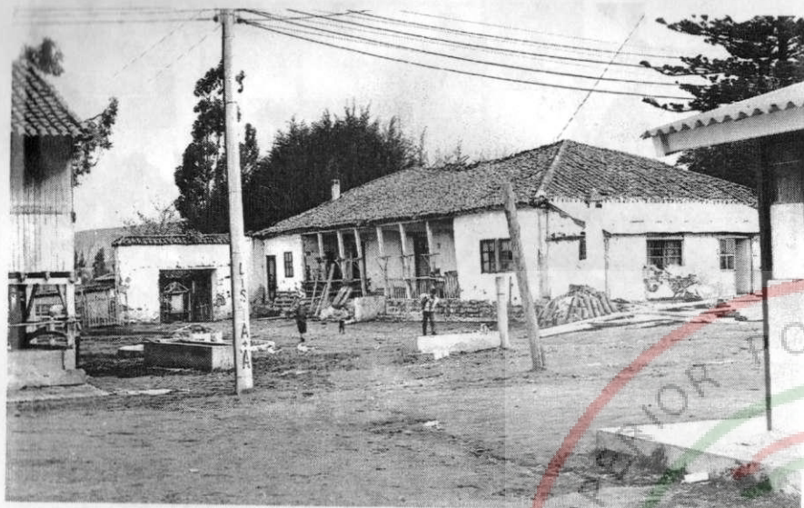
La casa principal del predio Macaji en ruinas.
