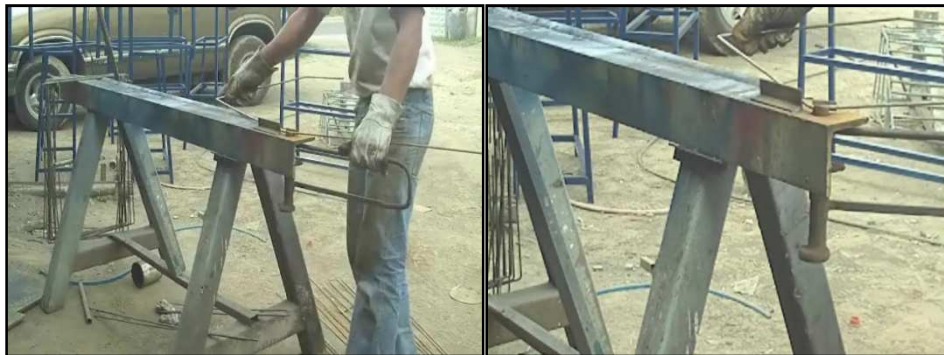
FIGURA 3. 38.- Doblado de varilla para marcos
