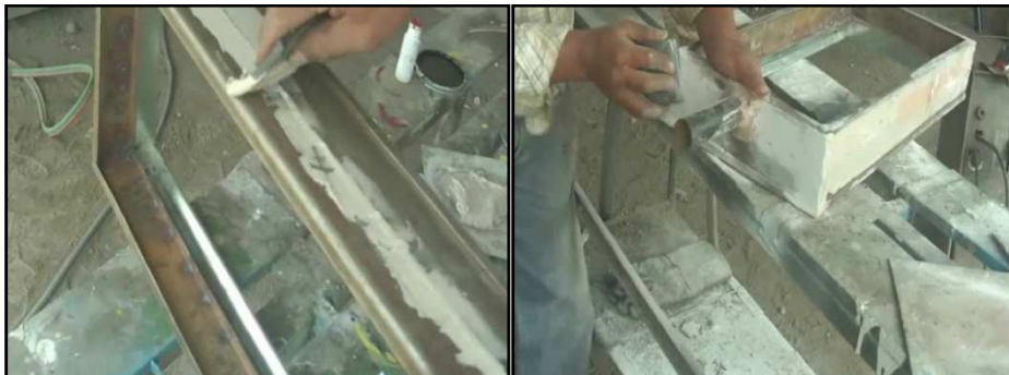
FIGURA 3. 17.- Masillado y lijado de esqueleto
