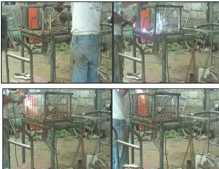
FIGURA 3. 42.- Unión de marcos con varillas de cruce
