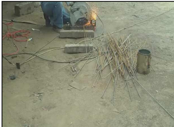
FIGURA 3. 37.- Corte de varilla para marcos
