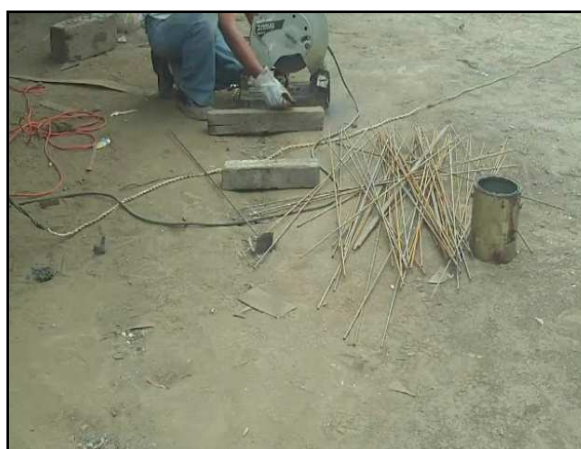
FIGURA 3. 43.-Corte de varillas para ganchos
