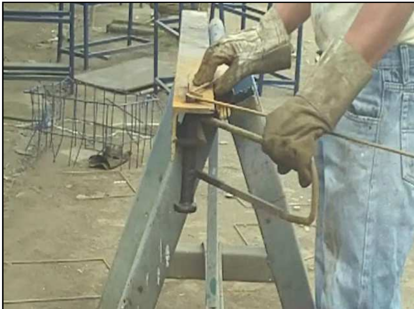
FIGURA 3. 41.- Doblado de varillas de cruce
