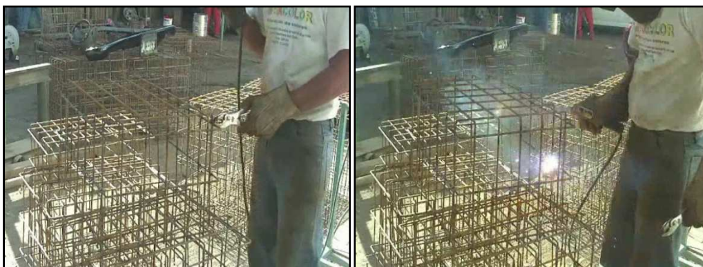
FIGURA 3. 45.- Unión de ganchos con canastilla y unión de cruces entre varillas
