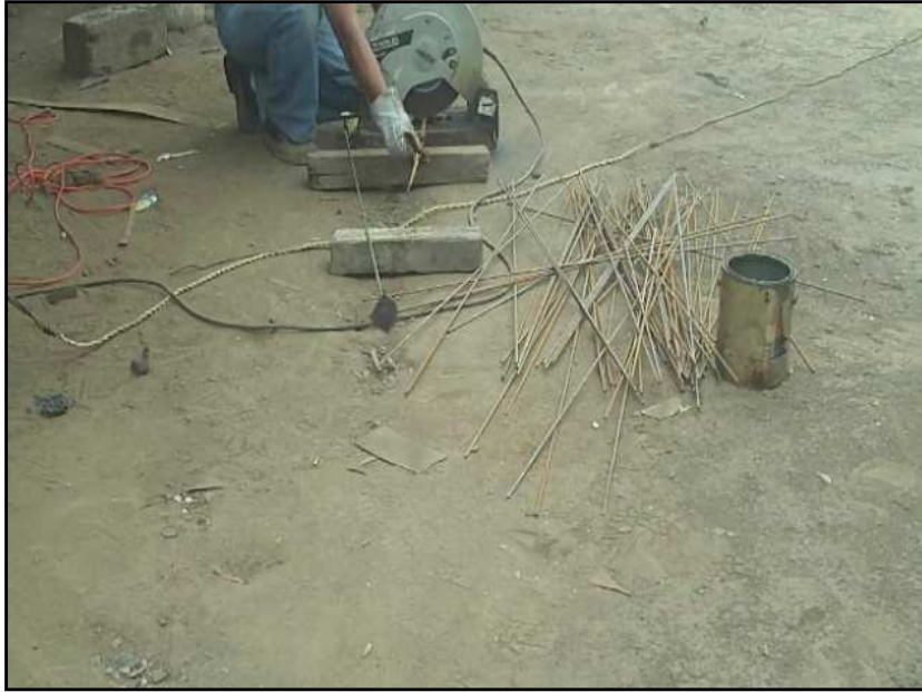
FIGURA 3. 40.- Corte de varillas de cruce
