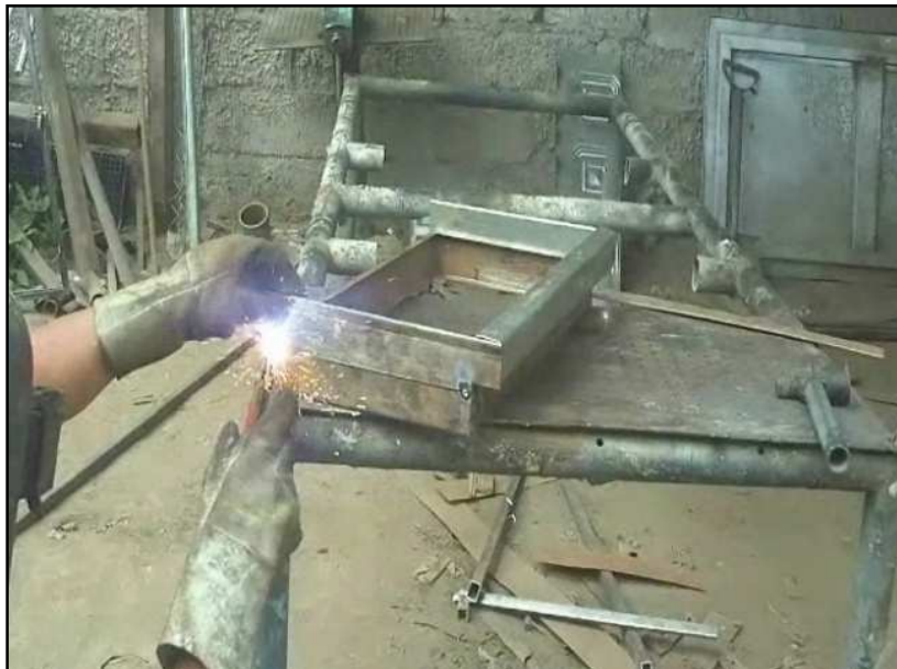
FIGURA 3. 15.- Unión de marco superior
