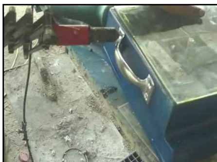
FIGURA 3. 23.- Colocación de la manilla
