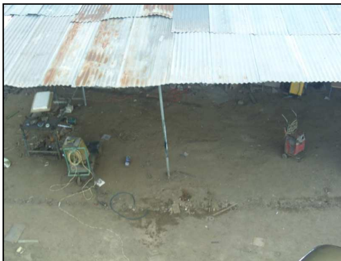
FIGURA 3. 4.- Cubierta de la empresa MARC METAL
