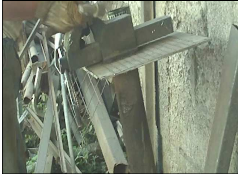
FIGURA 3. 44.- Doblado de ganchos con martillo
