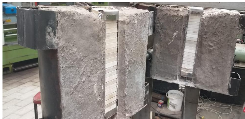
Figura 25-3. Montaje de resistencias eléctricas
