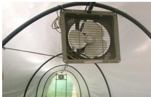
Figura 26-3. Montaje de los ventiladores
