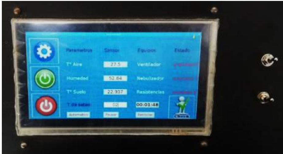
Figura 39-3. Pruebas preliminares del tablero de control
