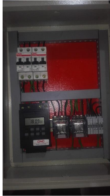
Figura 25-5 Instalación del sistema fotovoltaico
