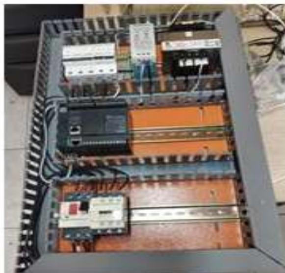
Figura 41-3. Instalación del tablero de control en el banco de pruebas oleohidráulico.
