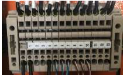
Figura 30-3. Borneras de riel DIN
