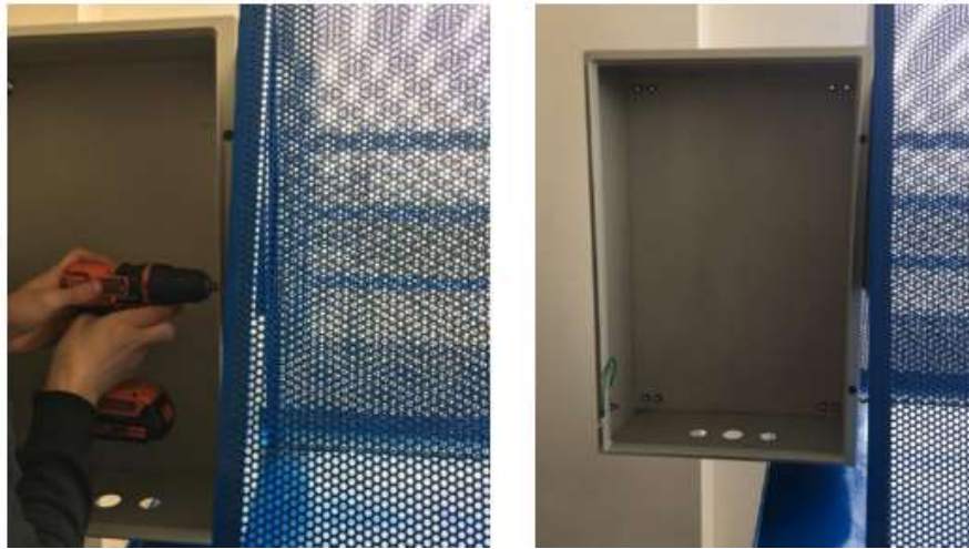
Figura 42-3. Instalación de caja térmica a banco de pruebas oleohidráulico.
