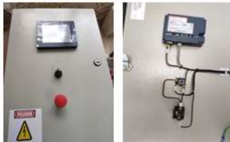
Figura 43-3. Instalación de puerta de la caja térmica.
