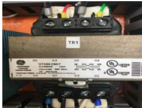
Figura 21-3. Transformador de núcleo y bobina.
