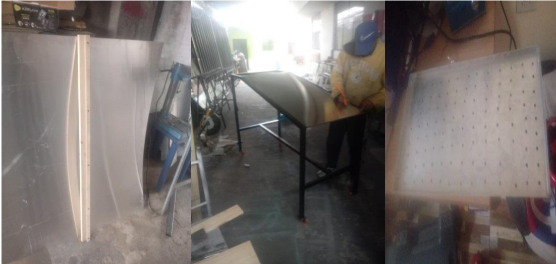
Figura 3-4: Proceso de construcción del colector solar Realizado por: Yumbillo, Braulio, 2019
