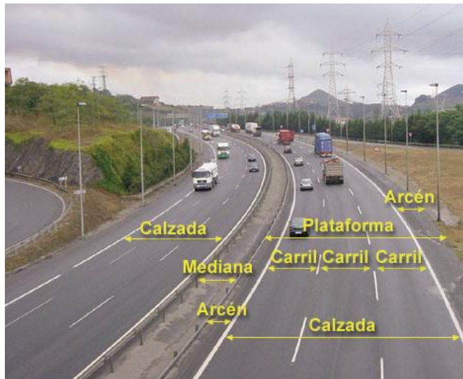
Figura 6-1: Partes de la Vía
