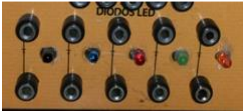
Figura 40-3: Instalación de los diodos LED parte externa Fuente: Autor
