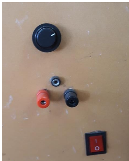
Figura 35-3: Instalación de la fuente regulable parte externa Fuente: Autor
