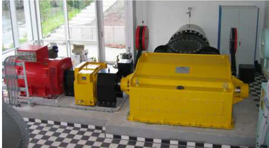
Fig. 2. 2. Turbina Michell Banki y generador eléctrico
