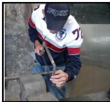
Figura 5.14. Medición y corte de tubos.
