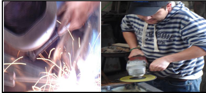
Figura 5.15. Unión por soldadura y pulido
