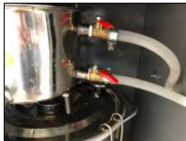
Figura 22-3: Válvulas de paso ¼” accionadas
