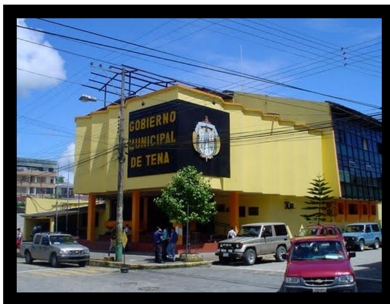
GRÁFICO N° 34 Edificio del Gobierno Autónomo Descentralizado Municipal del Cantón Tena
