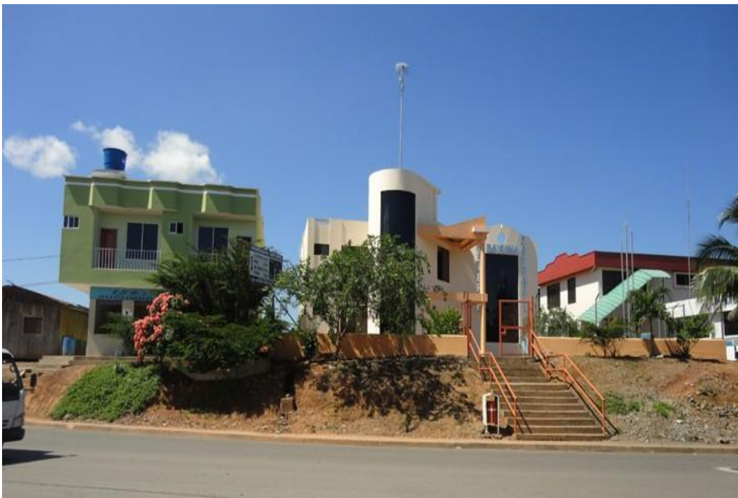
Figura 3: Edificio GADR Dayuma
